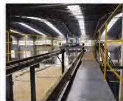
安装现场 Installation site
