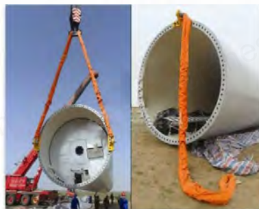
塔筒吊具 Fan spreader
